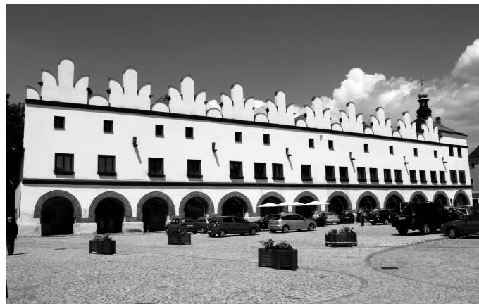
Severní strana náměstí po rekonstrukci
